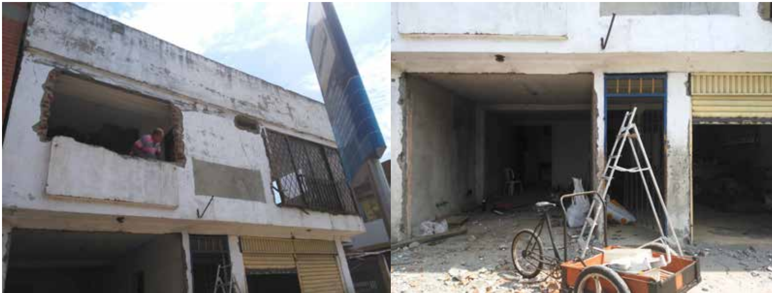
Adecuación estructura comedor Padre Rodrigo Molina/ Santiago de Cali
